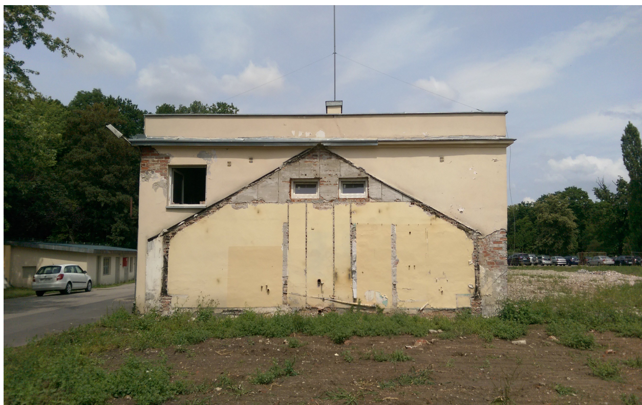
Fot. Nr 4 Widok elewacji południowej i planowanego dojazdu do kontenerów „morskich”
