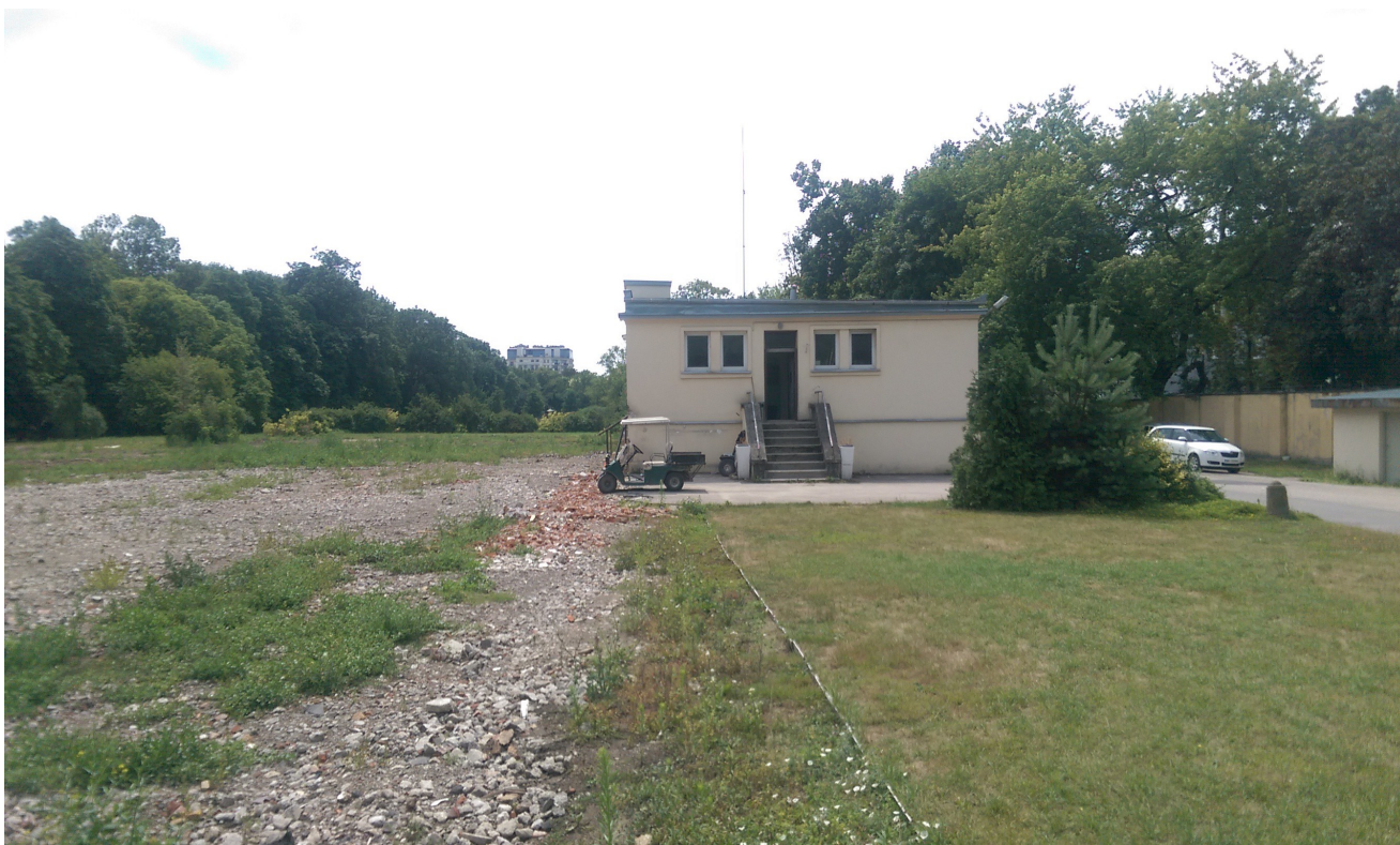
Fot Nr 2 Widok elewacji północnej budynku socjalno-gospodarczego
