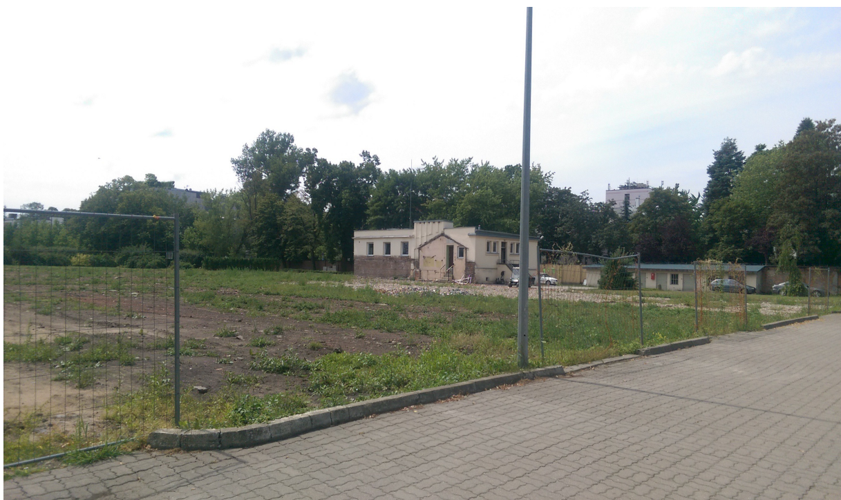
Fot. Nr. 1 Widok terenu planowanego magazynu kontenerowego z widoczną elewacją wschodnią i północną budynku socjalno-gospodarczego.
