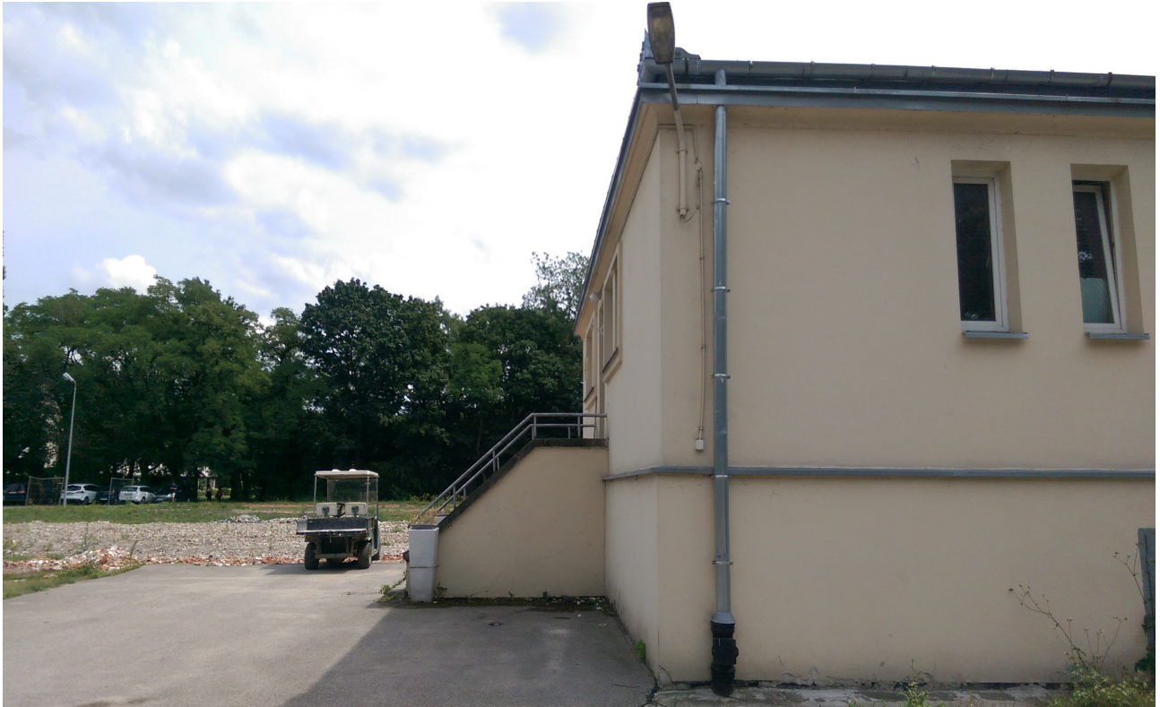
Fot. Nr. 5 Widok na Aleje Chińską i Nową Oranżerię za drzewami oraz fragment elewacji zach.
